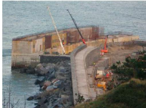
Les sollicitations sur les structures sont importantes. On discerne les points d'impacts sur le mur de front et sur la base ouverte de la chambre.
