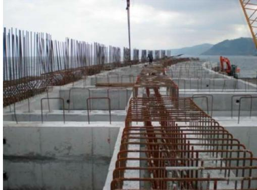
5. Scellement des éléments préfabriqués et construction de la galerie des turbines. Comblement des zones entre la centrale et le corps de digue.
