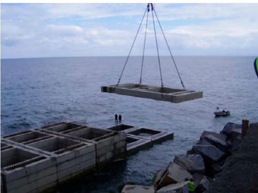
4. Mise en place des éléments préfabriqués par grue. 12 éléments par chambre.
