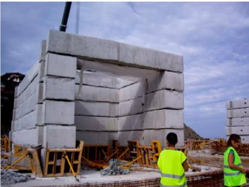
3. Mise en place des éléments préfabriqués par grue. 12 éléments par chambre.
